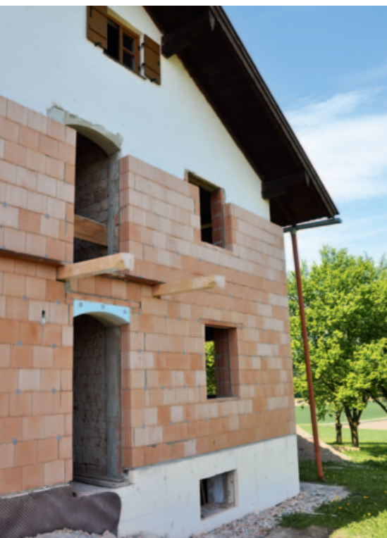
Ziegel mit Füllung aus Perlit
