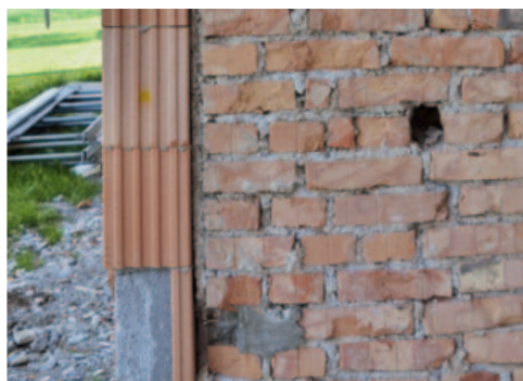
Ziegel mit Füllung aus Perlit
