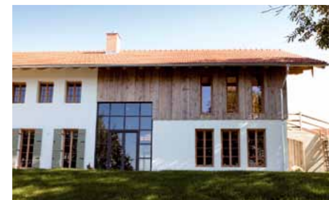
Die Westseite des sanierten Gebäudes zeigt rechts die frühere Remise. Schmale Fenster und Türen sollen die geschlossene Wirkung des Baukörpers mit seiner Holzverschalung nicht stören.
