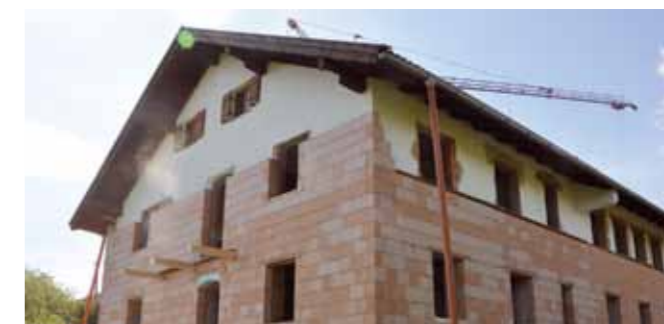
POROTON®-WDF kann je nach Beschaffenheit der Bestandswand wahlweise ohne weitere vorherige Maßnahmen knirsch oder im Abstand von zwei Zentimetern zum Bestandsputz vorgemauert werden.
